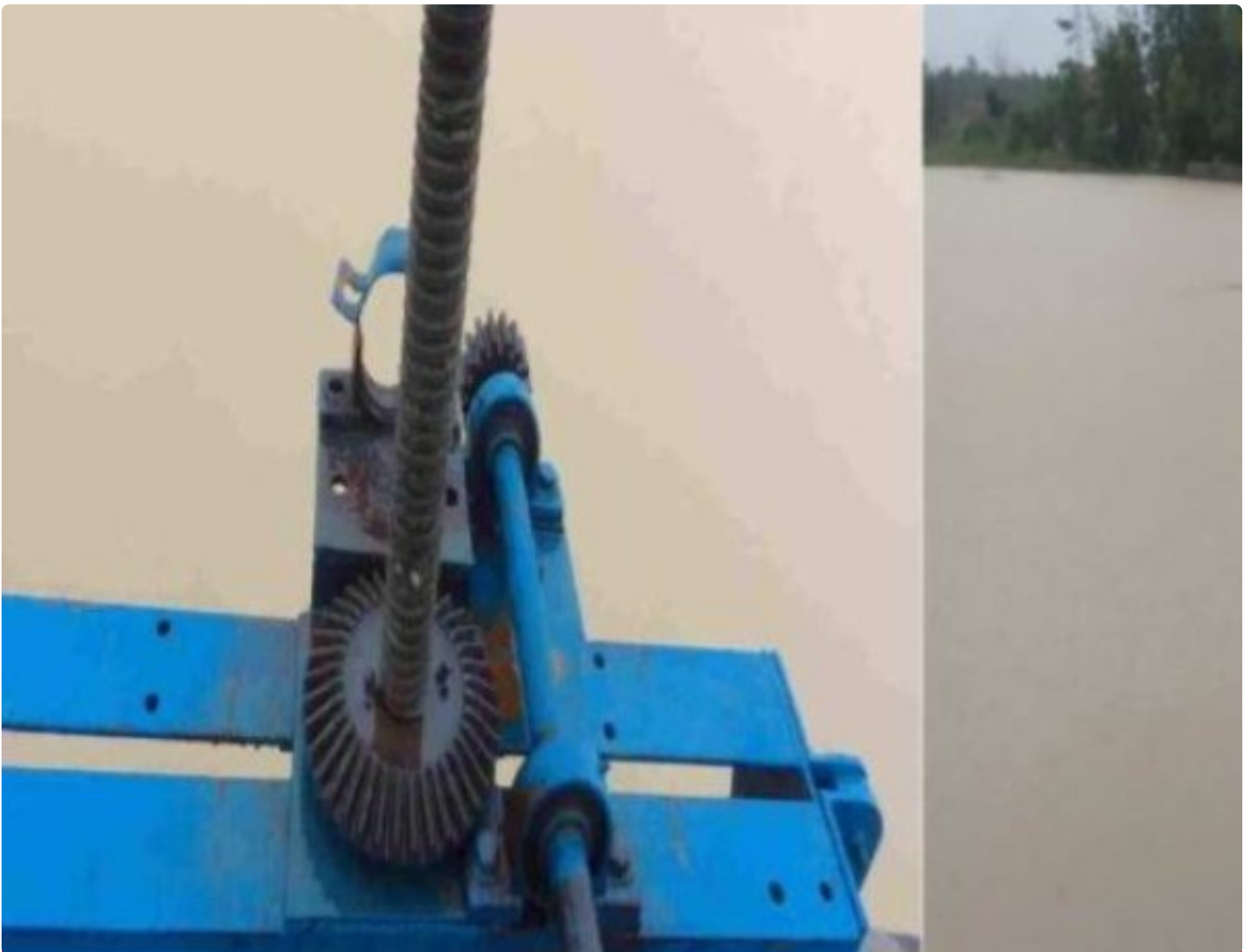
Pintu air Albaret Simpang Mesuji
